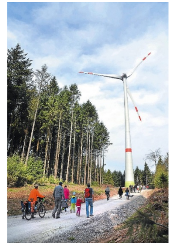
Fertiges Windrad am Greiner Eck (April 2017)
